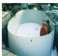
Struttura in acciaio
